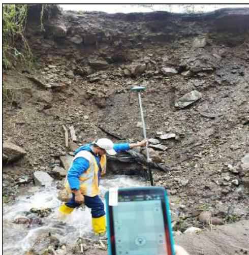
Levantamiento topográfico con sistema RTK, en la vía Alóag Santo Domingo Km. 37400.
