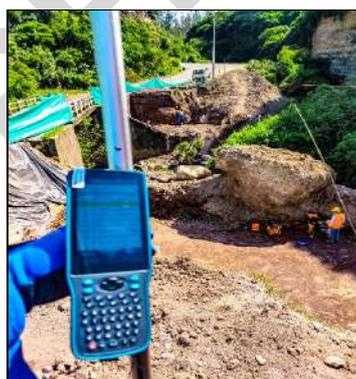
Levantamiento topográfico de precisión con sistema RTK, comprobando niveles de la subrasante de zapatas del puente Rumihuaico, ubicado en la parroquia Píntag.
