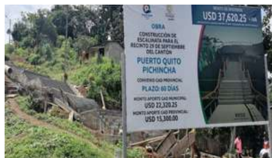
Construcción de escalinata para el Recinto 29 de Septiembre
