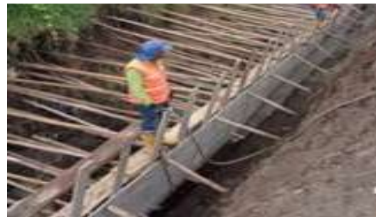
Mejoramiento del canal principal sistema de riego El Pisque, cantones Cayambe y Distrito Metropolitano de Quito.
