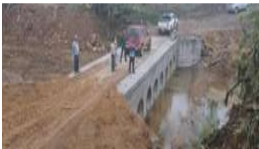
Alcantarilla en batería sobre el Río Piedritas, vía Ventanas - San Francisco de La Caoni
