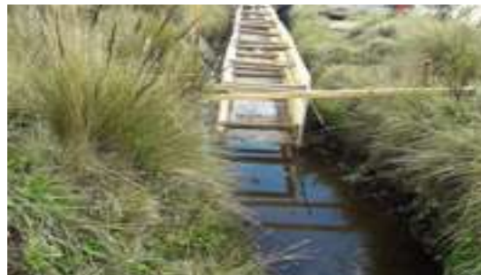
Mejoramiento del canal principal del sistema de riego Las Compañías, Tramo Verde Pamba, parroquia Cangahua, cantón Cayambe.
