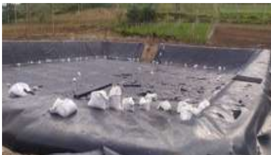
Impermeabilización del reservorio del sistema de riego acequia Piango, parroquia Puéllaro, cantón Quito
