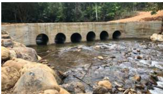
Alcantarilla en batería sobre el Río Biringo, vía Los Naranjos - Guayaquil Chiquito
