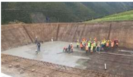
Construcción de reservorio por cogestión. Calvario La Chimba, parroquia Olmedo, cantón Cayambe.
