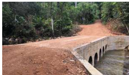
Alcantarilla en batería sobre el Río Biringo, vía Los Naranjos - Guayaquil Chiquito
