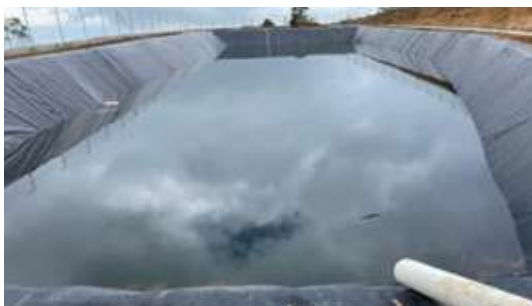
Impermeabilización del reservorio El Carmen, parroquia Checa, cantón Quito
