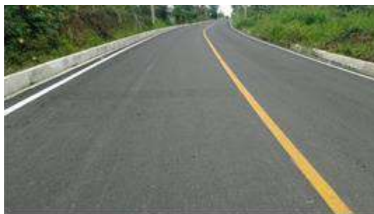
Proyecto: Doble Tratamiento bituminoso, drenaje y señalización de la vía la Célica y 15 de mayo, tramo 6 km Cantón Pedro Vicente Maldonado
