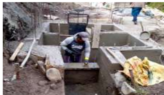
Construcción por cogestión de infraestructura de riego. Sistema de riego Calvario La Chimba, parroquia Olmedo, cantón Cayambe.
