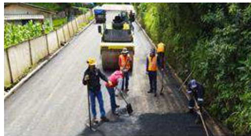
Vía Curipungo - Los Tubos
