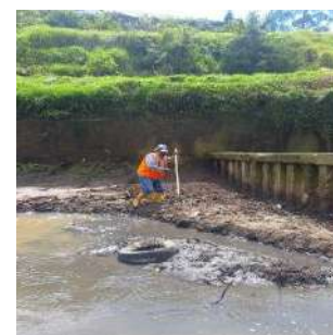
Limpieza de quebradas
