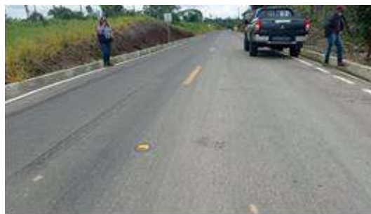
Proyecto: Doble Tratamiento bituminoso, drenaje y señalización de la vía la Célica y 15 de mayo, tramo 6 km Cantón Pedro Vicente Maldonado
