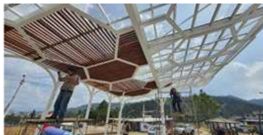
Construcción de una cubierta traslúcida con materiales mixtos, en estructura metálica y madera en el parque Central de Gualó
