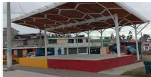
Construcción de una cubierta traslúcida con materiales mixtos, en estructura metálica y madera en el parque Central de Gualó
