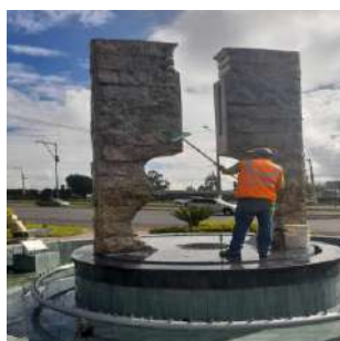
Mantenimiento de la pileta puente N°8
