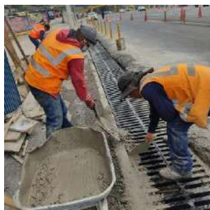
Trabajos de obra civil
