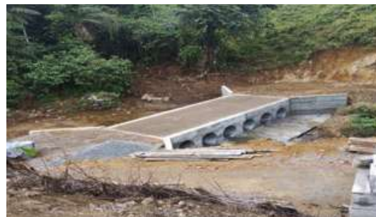
Alcantarilla en batería sobre el Río la Mona, San Dimas - Río Guayllabamba
