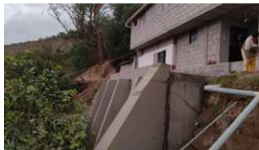
Construcción de muro y revestimiento de tramo crítico. Canal de riego Pueblo Viejo, parroquia Guayllabamba, cantón Quito
