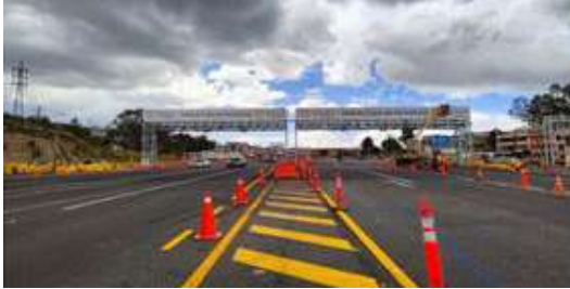
Servicio del Sistema Flujo - Libre Multi - Línea (MLFF) para el peaje de la Autopista General Rumiñahui
