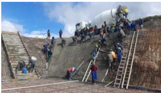
Construcción de reservorio por cogestión, sector Hierba Buena, parroquia Olmedo, cantón Cayambe
