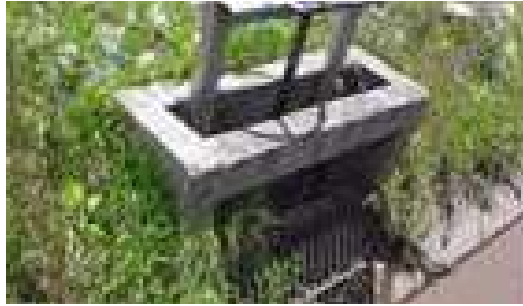
Proyecto: Obras complementarias para los dos reservorios emergentes, sector Yanatola, Parroquia Malchingui Cantón Pedro Moncayo.
