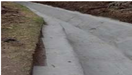
Revestimiento con manto geosintético (manto de hormigón), mejoramiento del canal principal y ramales del sistema de riego Tumbaco, cantón Quito
