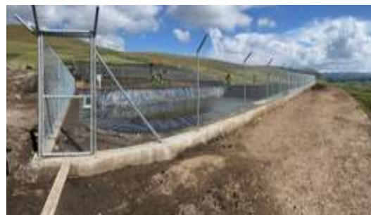
Impermeabilización del reservorio de la junta de riego Tulpashna, Monjas Bajo, parroquia Juan Montalvo, cantón Cayambe.
