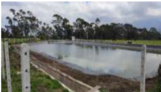
Terminación del sistema de riego Santa María y San José del Chisinche, parroquia Aloasí, cantón Mejía
