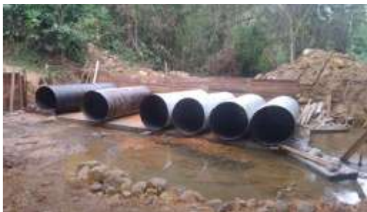
Alcantarilla en batería sobre el Río la Mona, San Dimas - Río Guayllabamba
