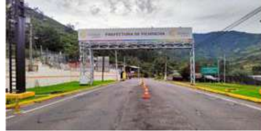
Servicio del Sistema Flujo - Libre Multi - Línea (MLFF) para el peaje de la vía Intervalles
