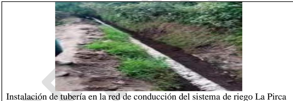
Instalación de tubería en la red de conducción del sistema de riego La Pirca
